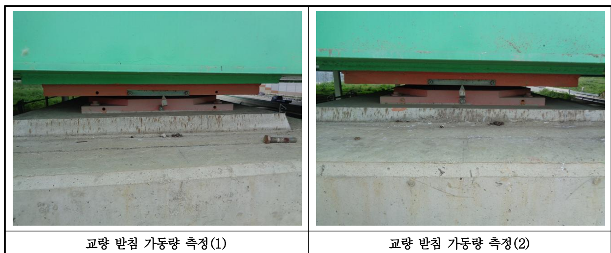
【사진 22.3.13】교량받침 이동량 측정
