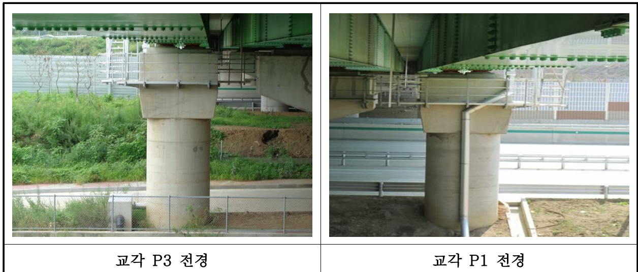
【사진 22.3.8】 교각 전경
