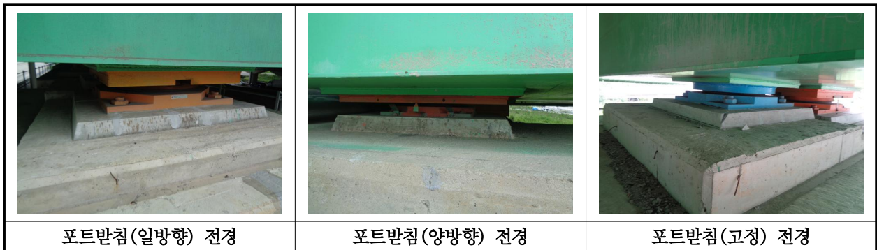
【사진 22.3.10】 교량받침 전경
