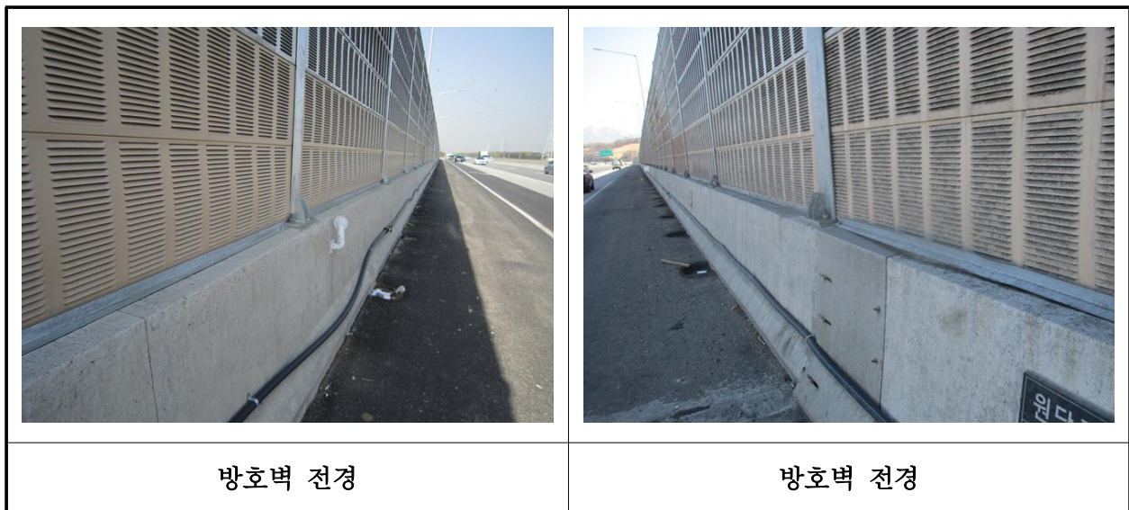
【사진 22.3.21】 방호벽 전경
