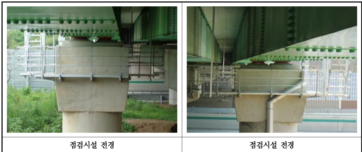
【사진 22.3.23】 교량 점검시설 전경
