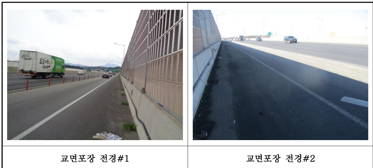
【사진 22.3.17】 교면포장 전경
