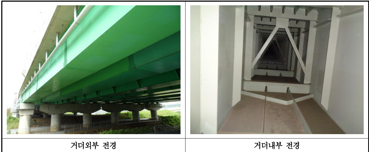
【사진 22.3.4】 거더 전경
