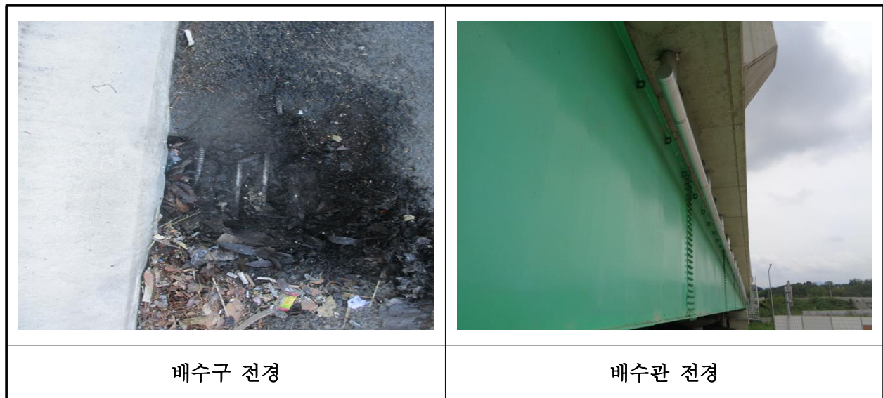
【사진 22.3.19】 배수시설 전경
